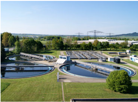
Die runden Nachklärbecken mit außenliegendem Überlauf
