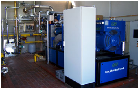
Das Gebäude mit den Blockheizkraftwerken, die täglich 3800 kWh Strom erzeugen
