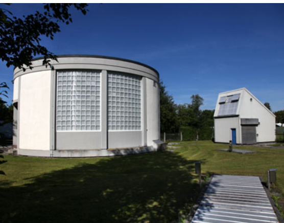
Hauptpumpwerk im Haberfeld mit erster Rechenanlage rechts im Bild
